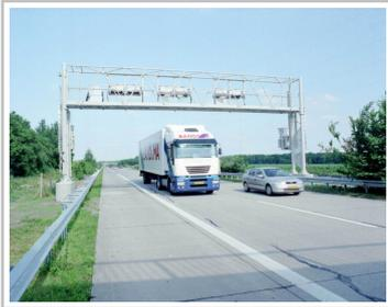
Kontrollbrücke zur Überwachung der Lkw-Maut.
